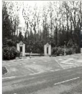
LVII/74/28 1997 Stabenow, Jörg ehem. Haupteingang an der Reichenhainer Straße
